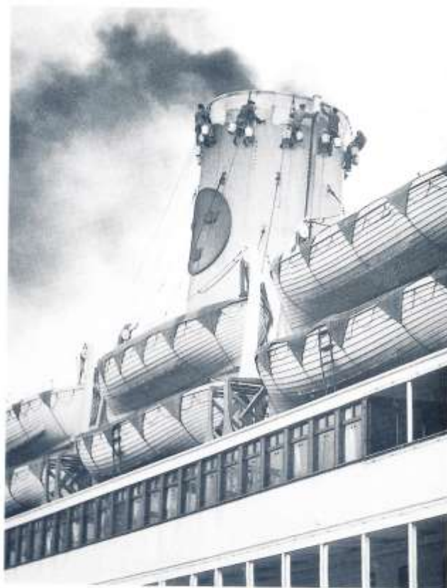
Här målas skorstenen på DROTTNINGHOLM, ett till synes arbetskrävande och otacksamt arbete. Skorstenen verkar ordentligt sotig. Foto och copyright Curt S. Ohlsson, Göteborg den 28/10 1947.
